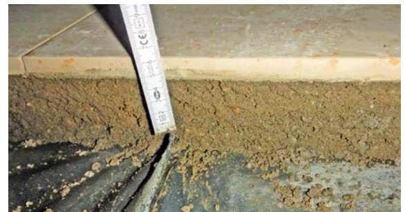
Folienfalten in der Trennlage
