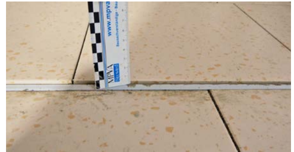
Überzähne nach dem Abrütteln
