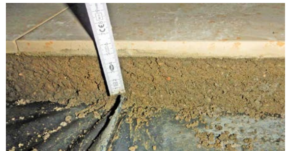
Folienfalten in der Trennlage
