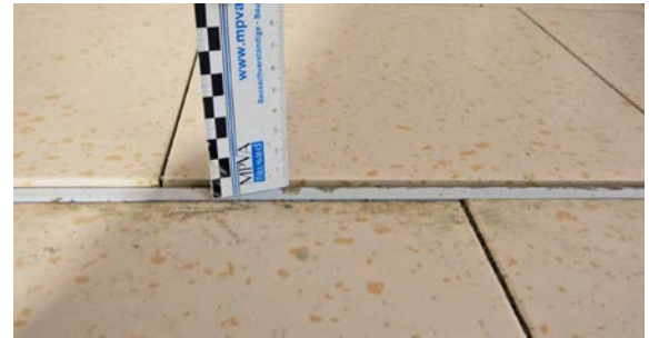
Überzähne nach dem Abrütteln
