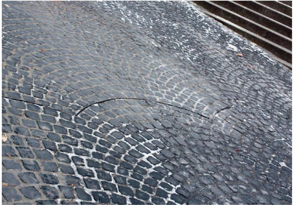
6. Schäden aufgrund einer zu hohen Verformbarkeit der Fugeneinlage.
