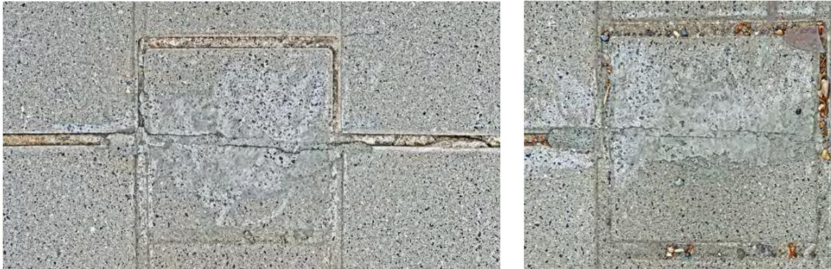
9. Sanierte Risse und deren optische Auffälligkeit.
