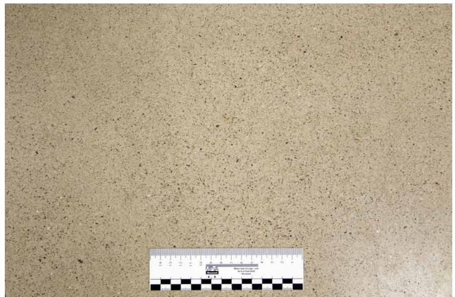
Abb. 1 a+b: Geschliffener und silikatisierter Industrieboden
