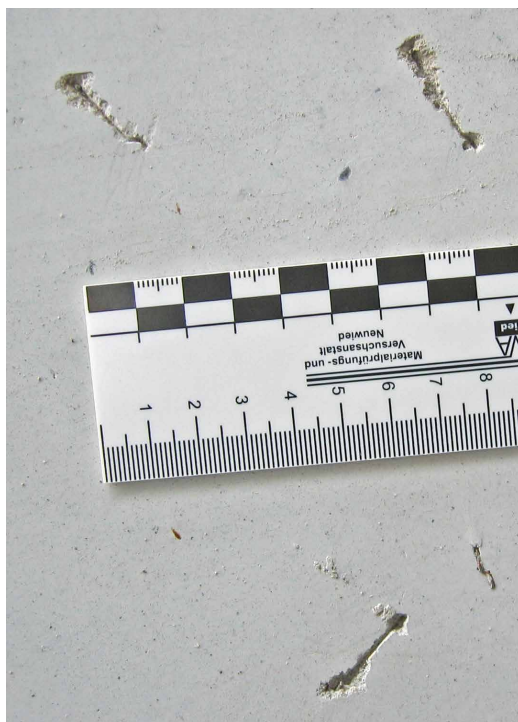
Abb. 10 a+b: In der Oberfläche des Industriebodens sichtbare, bzw. herausstehende Stahlfasern
