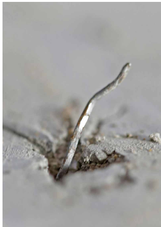
Abb. 10 a+b: In der Oberfläche des Industriebodens sichtbare, bzw. herausstehende Stahlfasern
