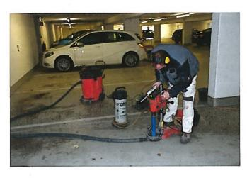
Abb. 3 a-c: Vorbohren mit Fixierung des Bohrständers
