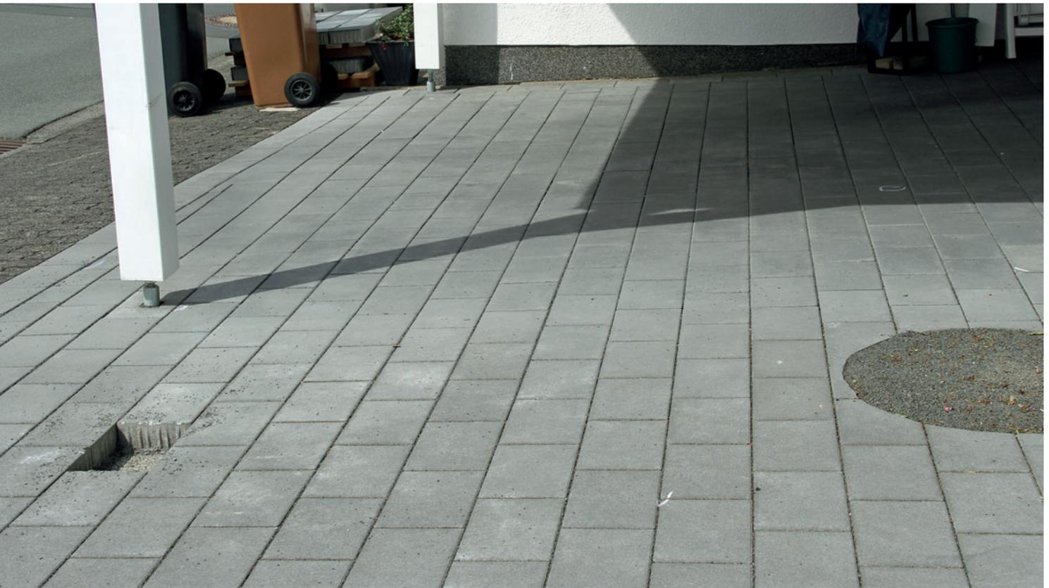
Abb. 1: Verfärbungen aufgrund von eingearbeitetem Fugenmaterial
