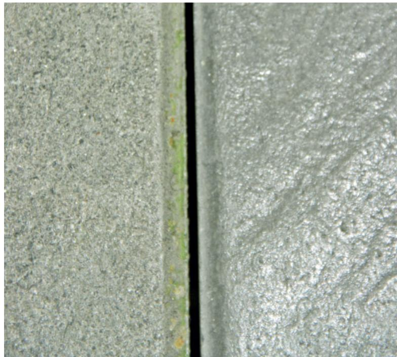
Abb. 2: Glanzverlust an vergüteten Betonplatten durch die Nutzung eines Spezialreinigers
