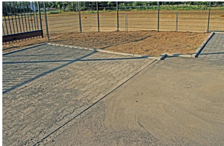
Abb. 5: Typischer Baustellenschmutz auf einer Pflasterfläche
