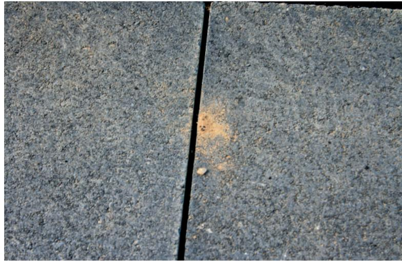
Abb. 4: Verschmutztes Pflaster bestehend aus vergüteten Betonplatten
