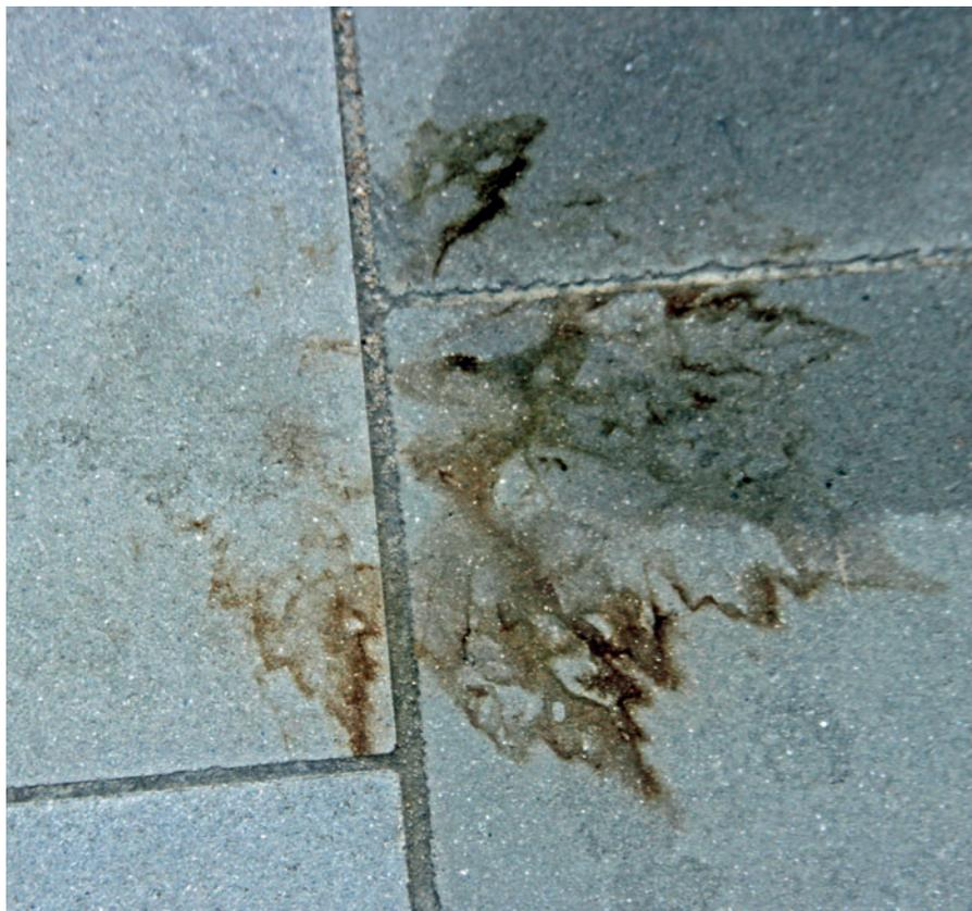
Abb. 3: Verfärbung von Betonplatten durch über lange Zeit einwirkendes Blattwerk
